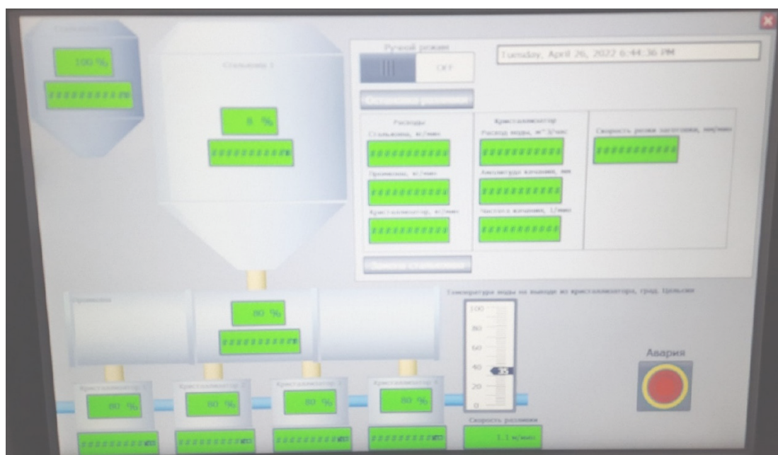
Рис.8. Работа HMI-панели под нагрузкой. Данные с контроллера не приходят и заменяются на символы «#»
